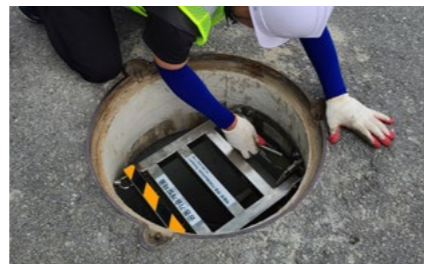
추락방지 접이식 안전판 설치된 모습
